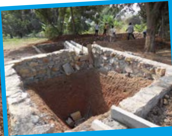
2. Absetzbecken für Sedimente (3x3m; ca. 10m 3 Fassungsvermögen)
