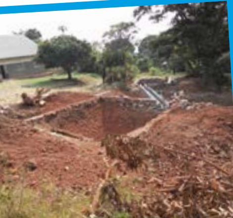
1. Absetzbecken für Sedimente (4x4m; ca. 15m 3 Fassungsvermögen)
