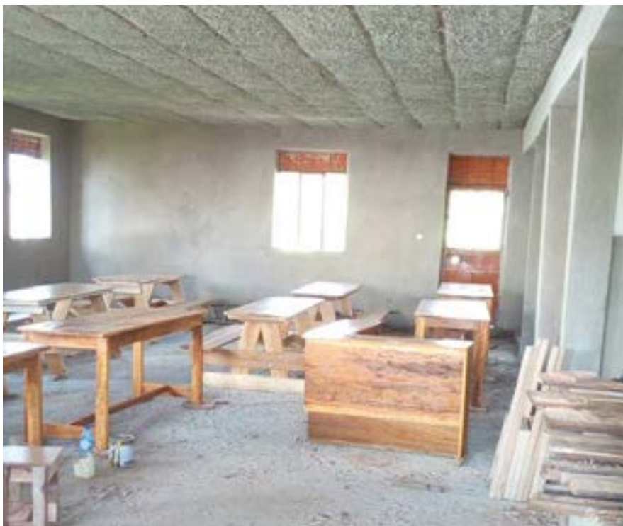
Die Baustelle der neuen Bibliothek am Hillside College Mityana
