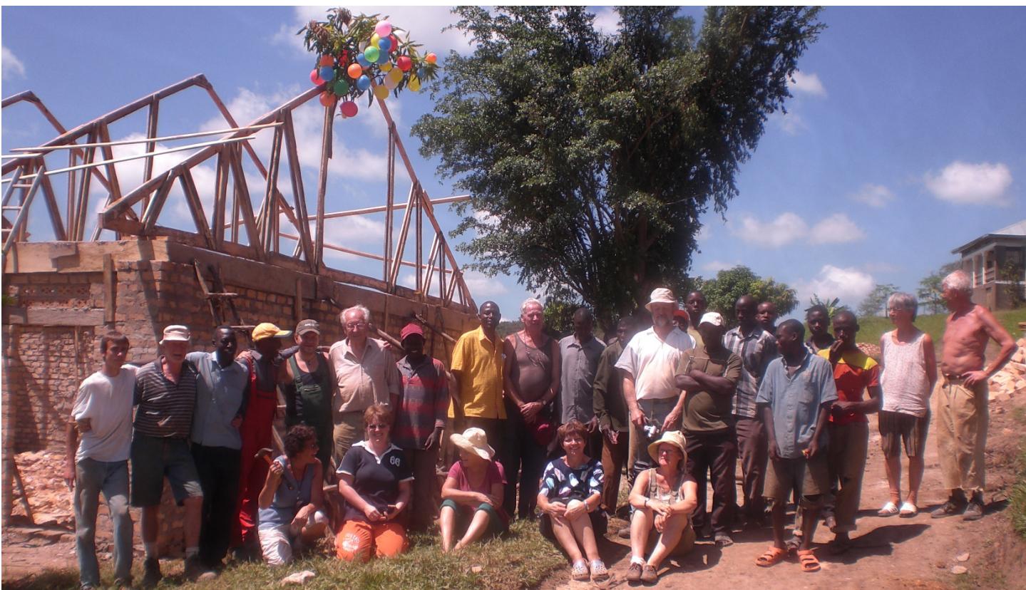
▼ „Buntgemischte“ Handwerker nach dem Aufrichten des Dachstuhls
