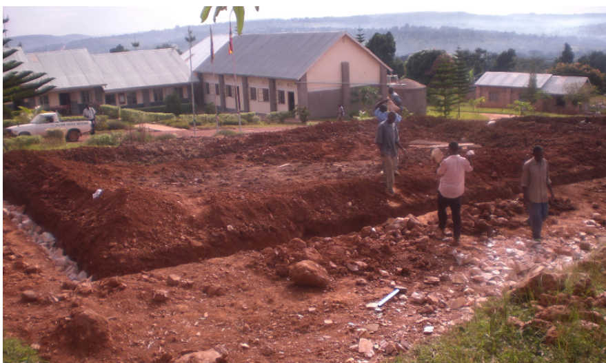
Baustelle beim Eintreffen auf dem Schulgelände
