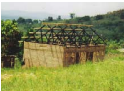
▲ Nebenbei errichtet: ein Wohnhaus für Lehrer
