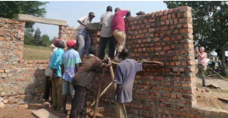
◀ Eine schwere Arbeit: das Aufsetzen der Fensterstürze
